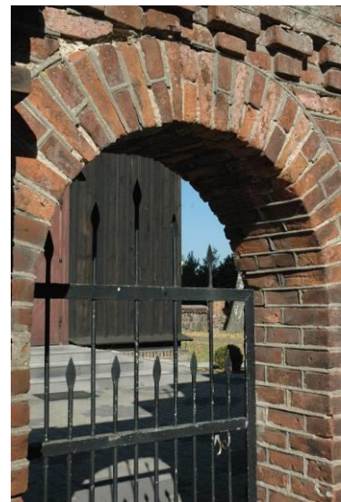
Fot. 1. Brama z cegły przy kościele w Niesułkowie (fot. A.Z.).
