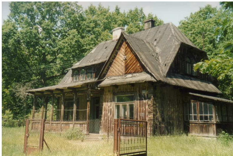
Fot. 10. Jeden z atrakcyjniejszych budynków na terenie BPK, mogący stanowić inspirację dla nowej zabudowy realizowanej w Parku.
